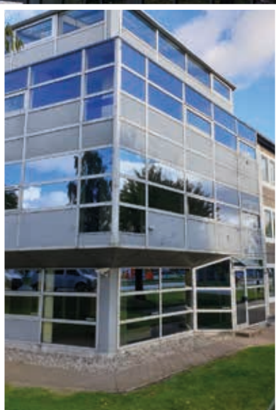
"Hjørnekontoret" før facaderenovering.
