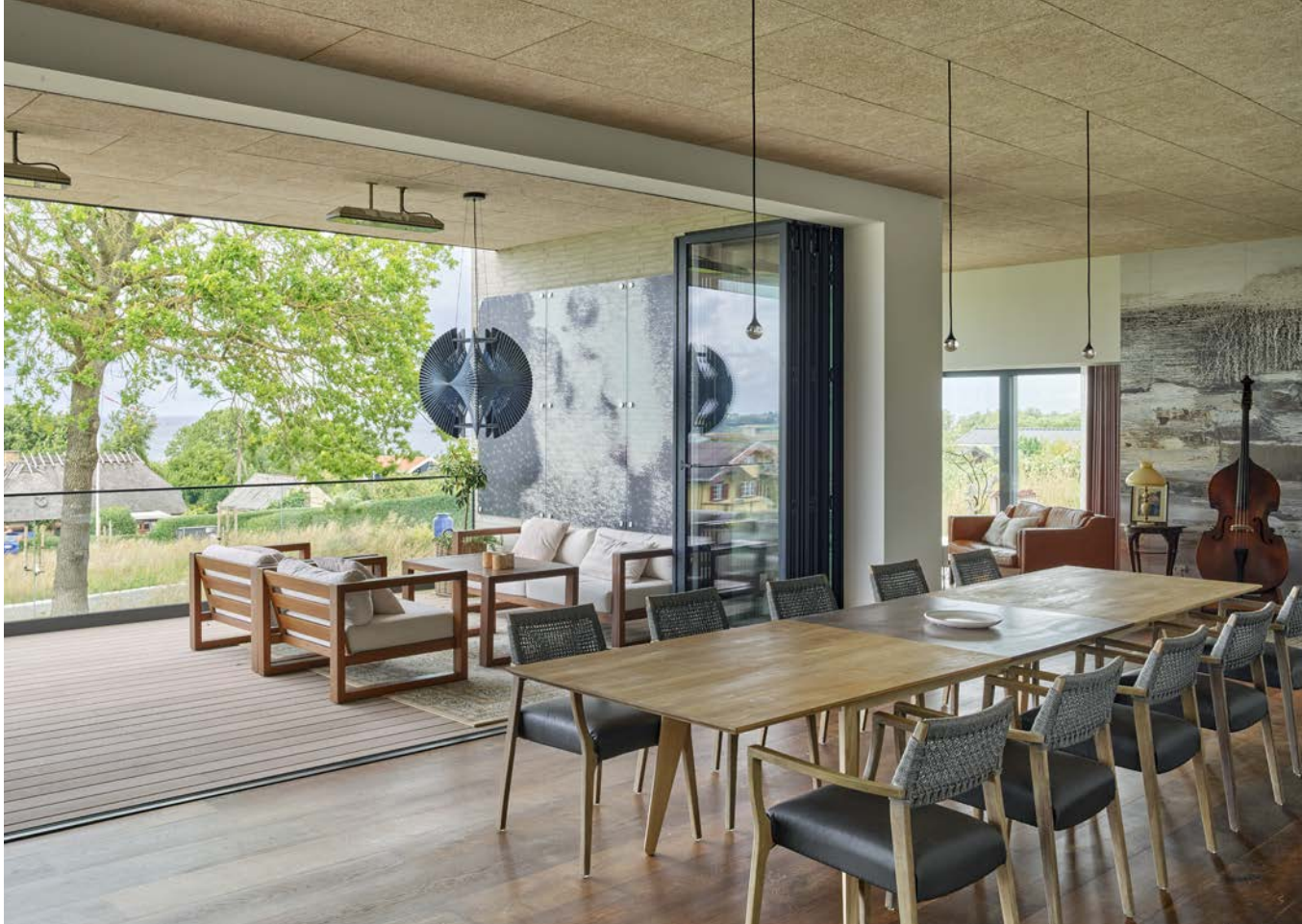
Foldedørene i villaen på Nordfyn er produceret med 3-lags ruder fra Glaseksperten og Schüco-profilsystemet ASS 80 FD.HI (foldedør, high-insulation).
