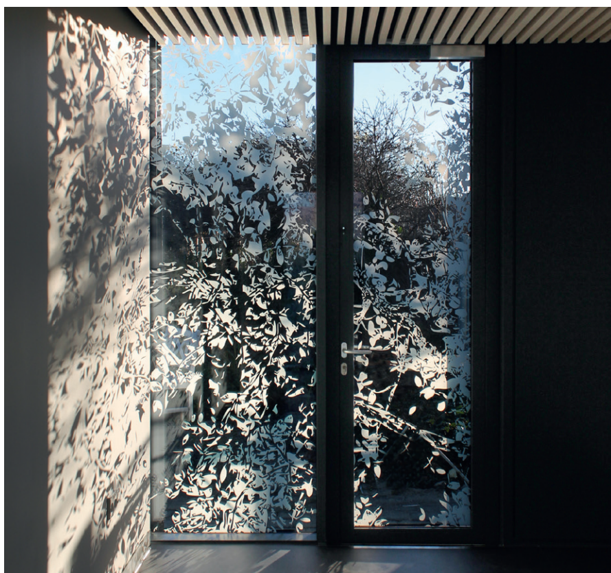
Printet giver en filtrering af sollyset, hvor skyggespil kommer til syne og varierer med vejr og årstider. Foto: Glaseksperten.
