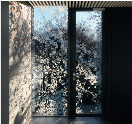
Keramisk printede birketræsgrene og -blade på 50 facadeglas Se side 10
