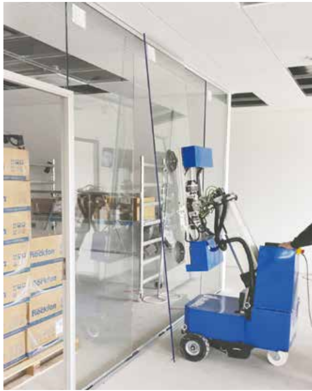
Wallmo kan montere enheder med dimensioner op til 3 m som her, hvor cobotten arbejder med en skillevæg af glas.
