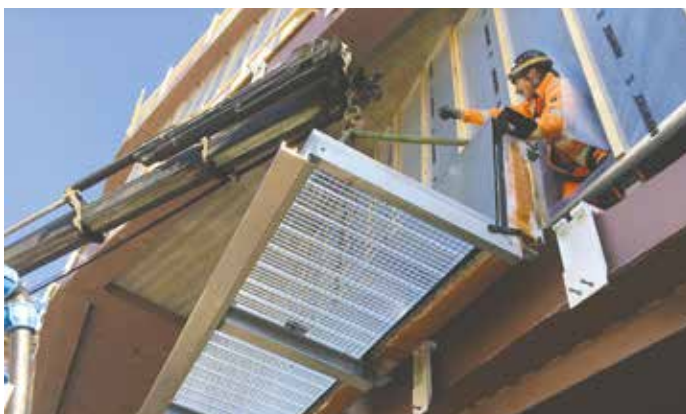
Et bund element er ved at blive monteret. Nå bund og top element er monteret monteres energiruderne frit spændende imellem dem.
