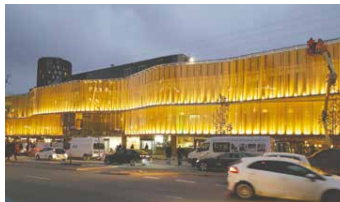
Den dynamiske facade kan i dagtimerne bruges til at skærme mod solen. Om aftenen og natten kan afskærmningen oplyses og give bygningen et varierende udtryk.
