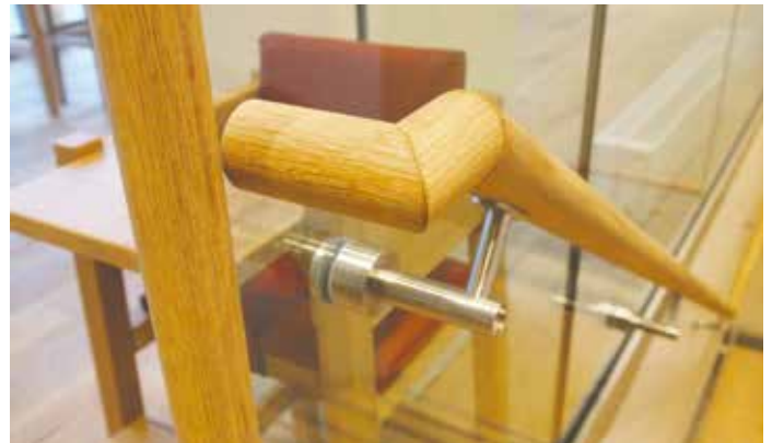
Glasværn med beslag fra Q-railings Pro-program, tilpasset den særlige håndliste fra Vapianos designmanual.
