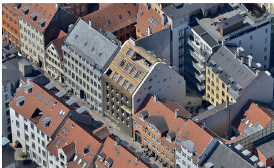
Lise Aagaard Copenhagens domicil: En tredjedel af facaden kan ændre funktion i forhold til lys og temperatur henover et døgn, fordi foldeskodderne i perforeret Tecu Gold kan trækkes op og lukkes.
