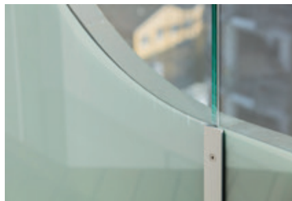
Detailfoto, der viser samlingen med blankpoleret F-kant.
