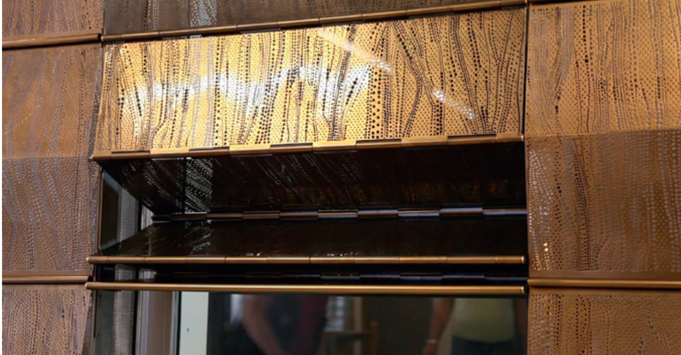
Lise Aagaard Copenhagens domicil: En tredjedel af facaden kan ændre funktion i forhold til lys og temperatur henover et døgn, fordi foldeskodderne i perforeret Tecu Gold kan trækkes op og lukkes.
