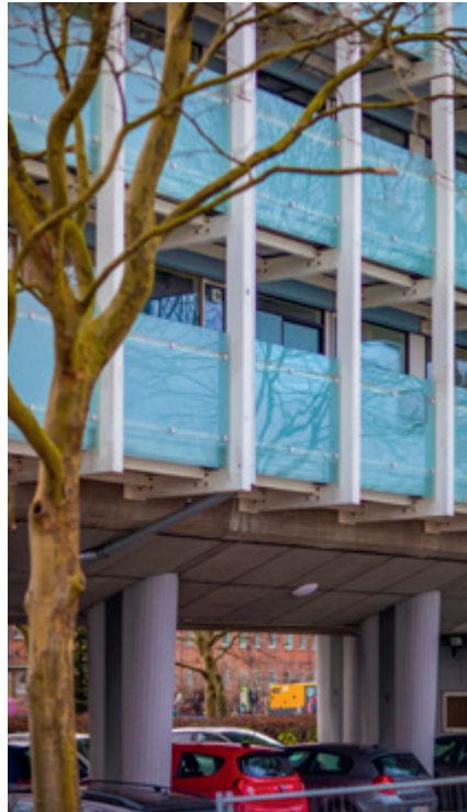
De 70 kg tunge værn har dimensionen B1920 x H1520 mm og er udført af 2 x 6 mm hærdet og lamineret glas med 0,76 mm mellemlagsfolie (6.6.1).
