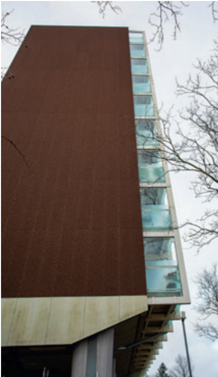
Betonbrystninger er erstattet af en stålkonstruktion af medløbere, dimension L2150 x B25 x H50 mm. Øverste medløber afsluttes med en håndliste af egetræ.
