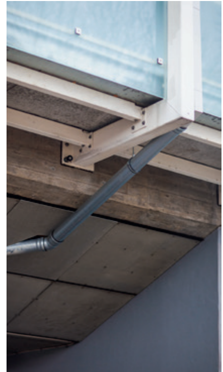
En afløbsløsning for regnvand har ført nedløbene ud i facaden, gemt langs de eksisterende stålsøjler.
