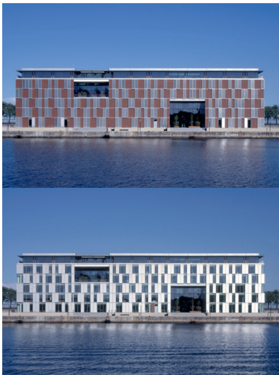
Pension Danmark: Skodden kan køre til og fra vinduet inden for sin ramme. Lamellerne, som skodden er bygget op af, kan vippe op og ned. Et enkelt system, der kun involverer én motor per enhed til to forskellige bevægelser. »
