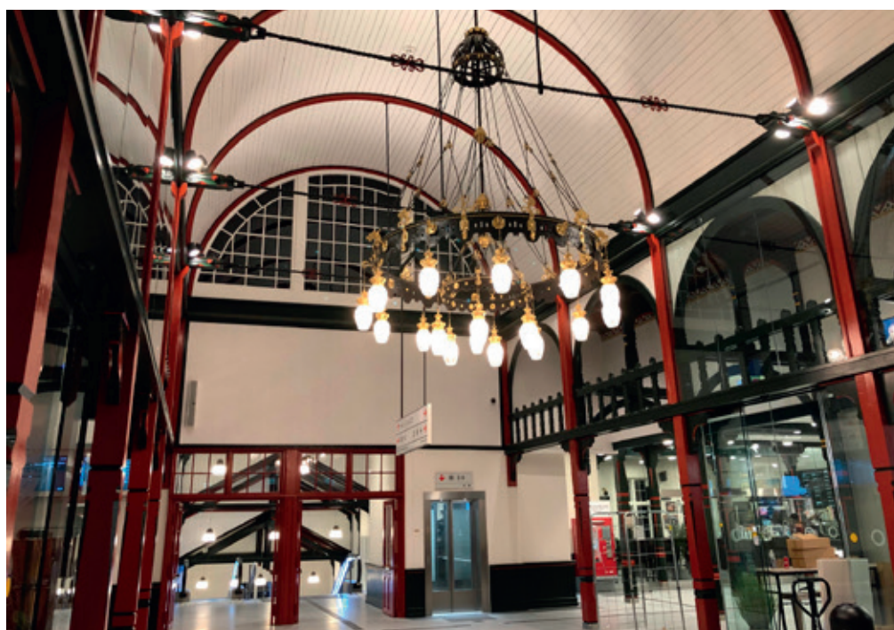
Til den nye station har Snoer Glas specialfremstillet to indgangspartier i glas, en glasvæg i to etager, der går fra stueplan til stationens nye førstesal.
