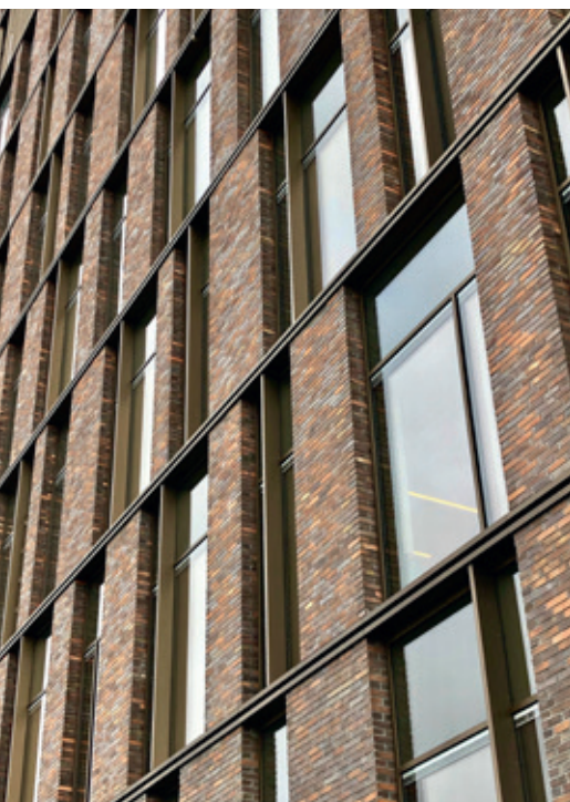
Det Grønne Strøg fremstår med de karakteristiske og dybe trekantslameller af gyldent anodiseret aluminium. Lamellerne er perforerede og filtrerer solens klys.
