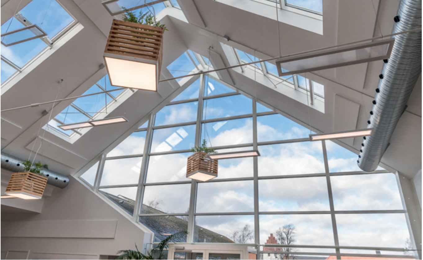
Gavlene er de eneste bygningsdele, som kun består af glas og aluminium.
