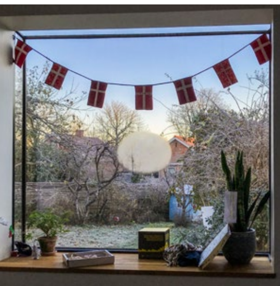
Indvendig kondens grundet den lille afstand mellem glassene.
