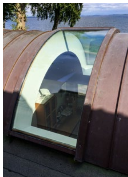
Den nye energirude er lagt op i det buede tag og sikrer, at der i de næste mange år vil komme et godt og naturligt lys ind i bygningen.
