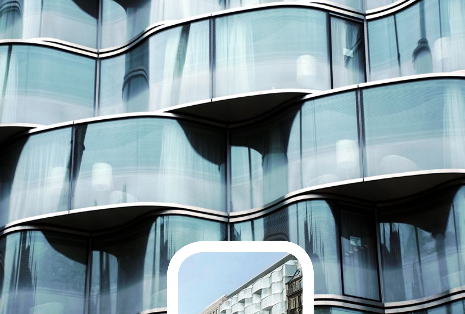
Hotel Renaissance® Wagram, Paris. Arkitekt: Christian de Pontzamparc. Ingeniør: HPM. Glasfacade: Seele. Ruder: tolags lavenergi med print. Spacer: Super Spacer® TriSeal™ Premium Plus. Dimension: 2600 × 4300 mm. U-værdi: 0,8 W/m²K.
