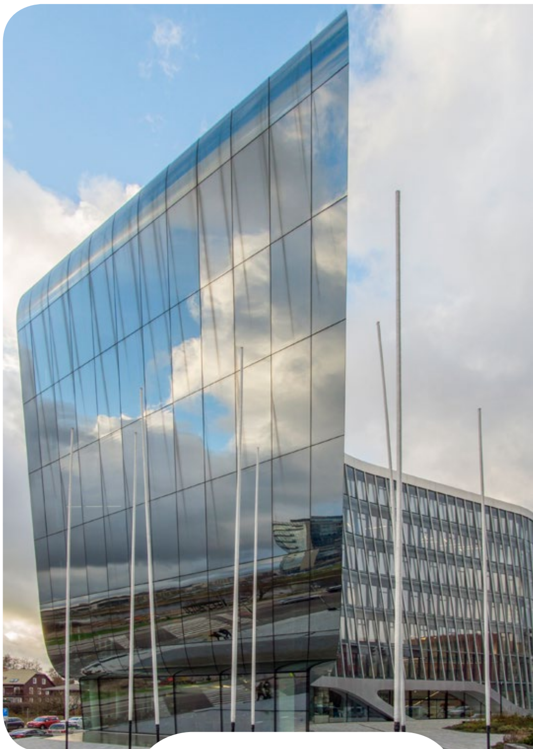
Green Hall 2, Vilnius. Arkitekt: Arrow Architects, København. Ingeniør: Ribinis Buvis UAB. Rudeproducent: Flintermann Glasveredlung GmbH. Rudedimension: 3800 × 2300 mm. Spacer: Super Spacer® TriSeal Premium Plus. U-værdi: 0,6 W/m 2 K.
