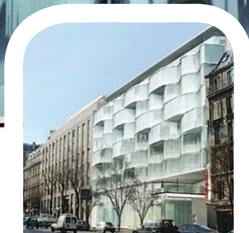
Hotel Renaissance® Wagram, Paris. Arkitekt: Christian de Pontzamparc. Ingeniør: HPM. Glasfacade: Seele. Ruder: tolags lavenergi med print. Spacer: Super Spacer® TriSeal™ Premium Plus. Dimension: 2600 × 4300 mm. U-værdi: 0,8 W/m²K.
