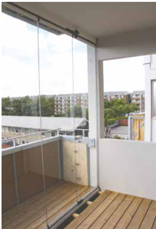
Det foldbare Lumon 6 system udmærker sig ved at være diskret og transparent, hvorfor den synlige adskillelse mellem altaner med og uden inddækning er minimal.
