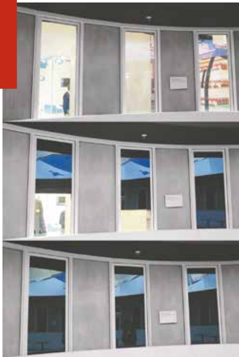
Guardian viste sit bud på en dynamisk glasløsning på basis af impulser med lavvolts strøm. Foto: Guardian.
