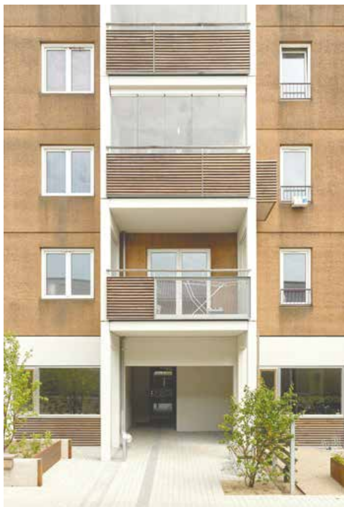
Hjortegården i Herlev: Ud af 500 boliger har 200 fået glasinddækkede altaner efter et projekt af Tegnestuen Vandkunsten A/S. Hovedentreprenør: Enemærke & Petersen A/S.
