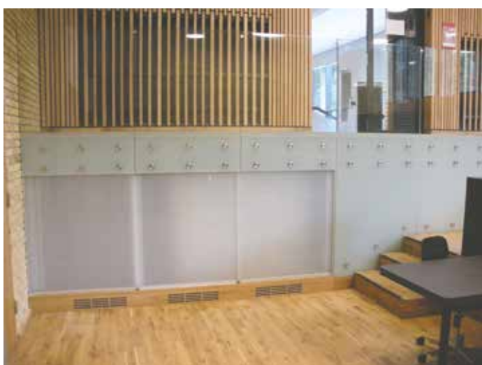
Under reposerne er der udført skabe til opbevaring af undervisningsmaterialer. Skabene er udført med skydelåger i glas, så de matcher glasværnet.
