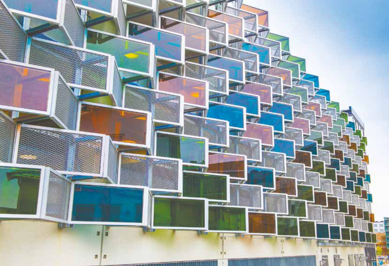
Eksempel på en BIPV installation med farvet glas: Parkeringshus i Vallastaden, Sverige. Produktion: Soltech Energy AB.
