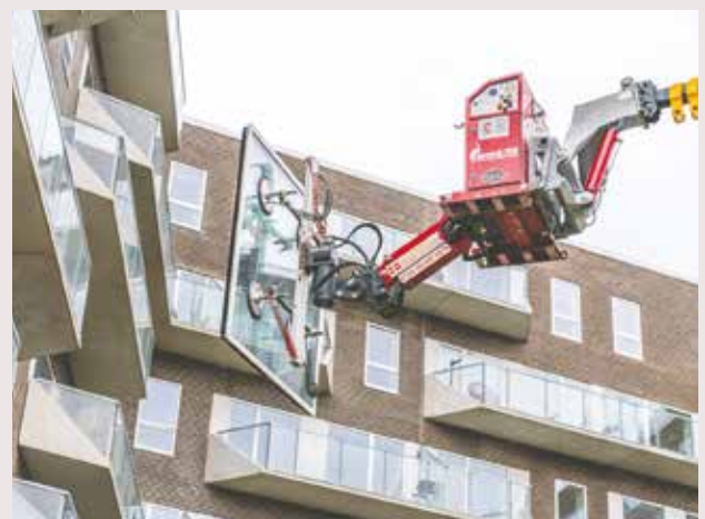
Temadag med ny viden om både elevatorglas og rude – og facademontage.
