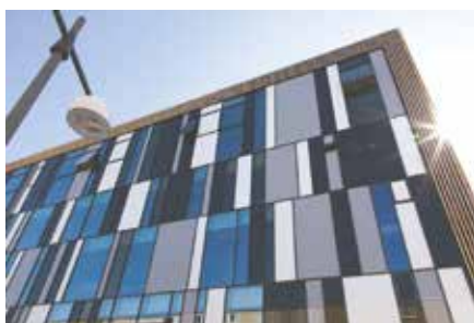
Tingbjerg Bibliotek og Kulturhus kan tolkes som en fladskærm med en facade som en sættekasse med mange forskellige rum. Arkitekturen står COBE A/S for.
