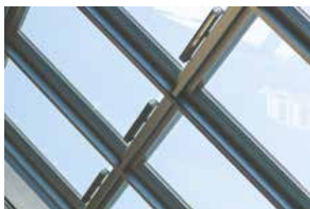
Profilet er udført med Schüco FW50+. Det gælder også opluk og to store ovenlys i dimension 5000 x 4000 mm, opdelt i otte felter, denne med opluk (Schüco Tip-Tronic) til røgventilation.
