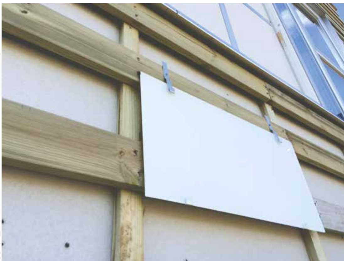
Glassene bliver monteret med aluminiumshafter der er fastgjort til krydsforskallingen.
