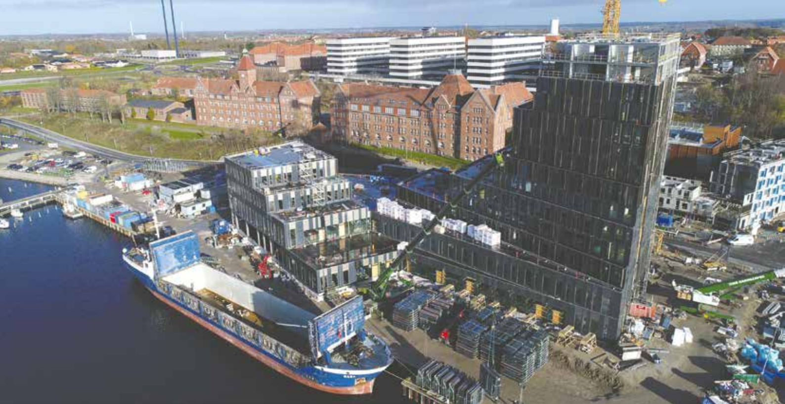
Alsik set fra oven. På havnen ligger facademodulerne der netop er losset fra skibet.
