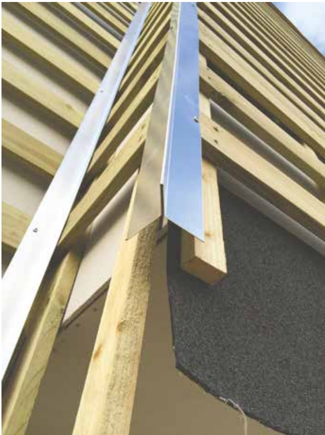
Ved alle hjørner er der monteret afslutningslister i aluminium.
