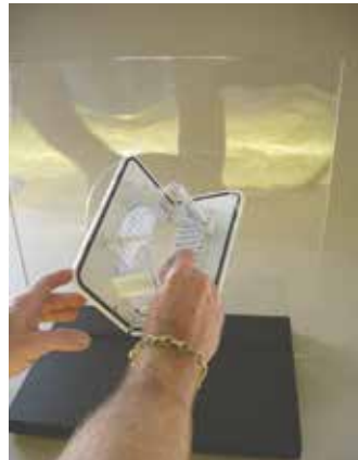
Ventilatorens udvendige jalousi klappes sammen, og stikkes ud gennem hullet i ruden.
