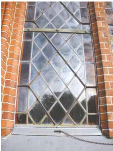
Blyruderne inden renoveringen.
