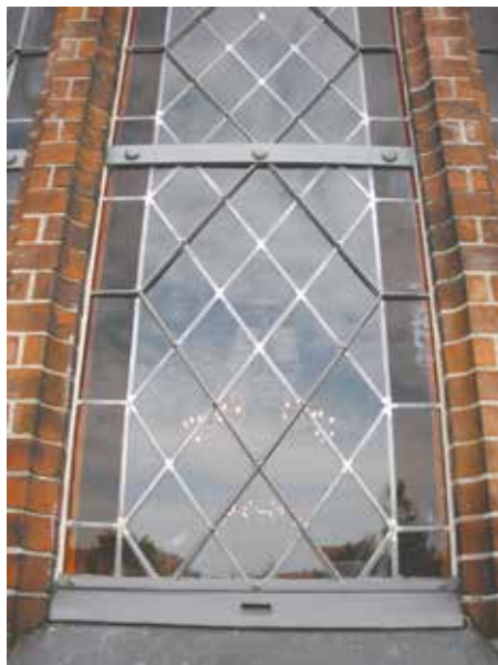
Blyruderne efter renovering.
