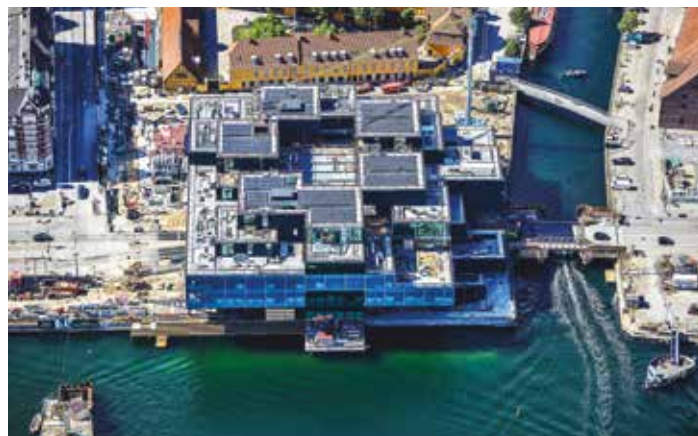
Et luftfoto af BLOX viser bygningens plandisponering med de sammensatte 'blokke' eller bokse omkring et atrium med et gavmildt ovenlys. Metallbau Früh fra tyske Umkirch er entreprenør.
