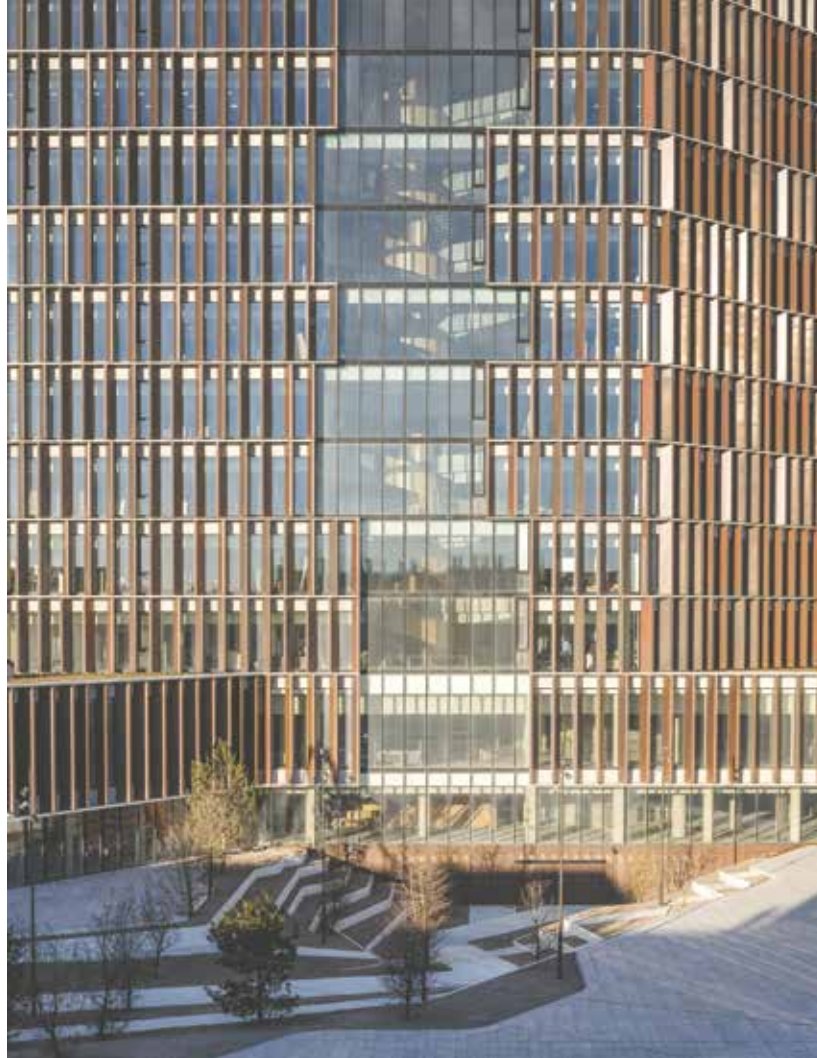
Mærsk Bygningen fremstår i en sikker komposition af glas og kobberbelagte finner, der for en tredjedels vedkommende er bevægelige efter klimaets energitilførsel.
