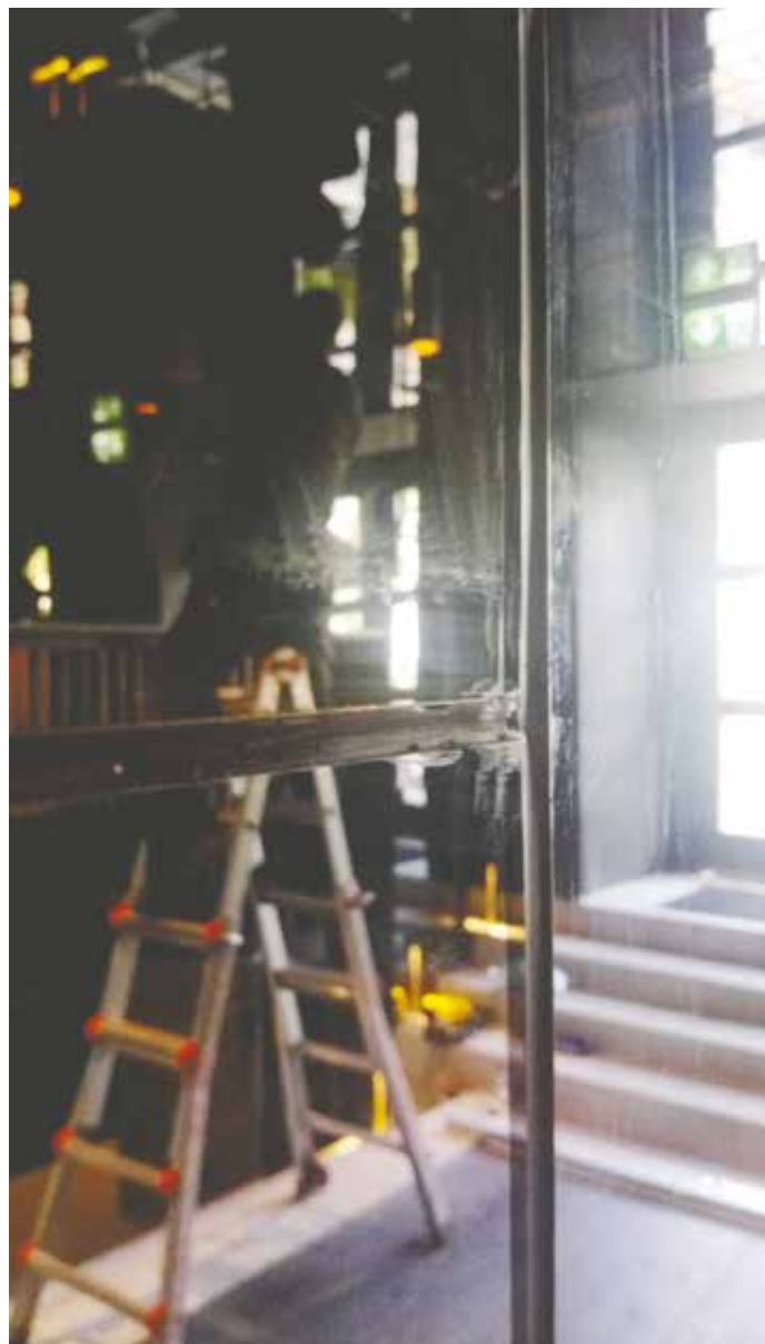
Samlingen imellem glassene er udført med sort rudelim. På billedet er spejlene endnu ikke pudset og gjort klar til aflevering.
