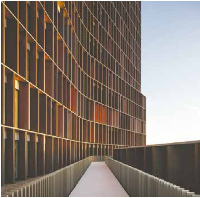
De kobberbelagte skodder danner en fascinerende struktur, der ændrer sig radikalt efter synsvinklen.
