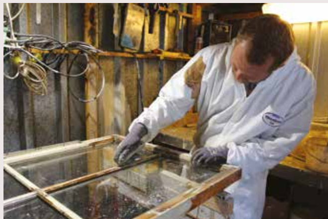
Håndværkeren i gang med at skrabe maling af gammel palæramme
