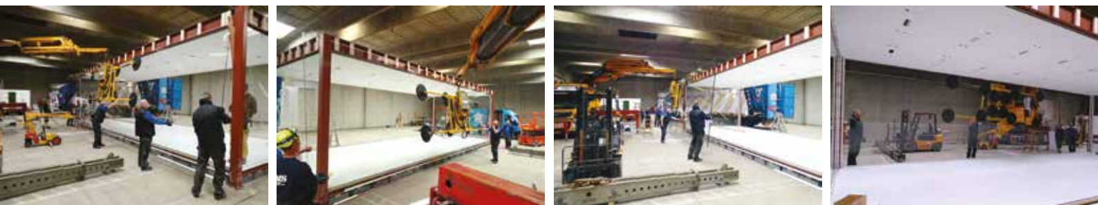
Specialudviklet udstyr og gennemtænkt planlægning var nødvendig, for at få de 2 ton tunge glas på plads i udstillingshallen i Århus.
