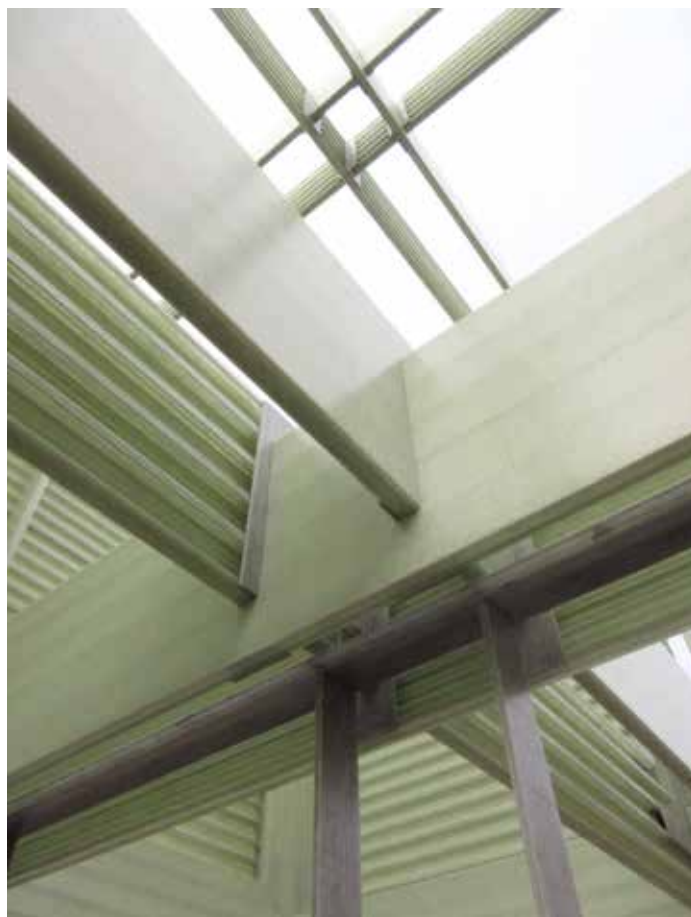
Bærende konstruktioner af glasfiber, produceret hos Fiberline A/S i Middelfart, har gennemgået omfattende tests.
