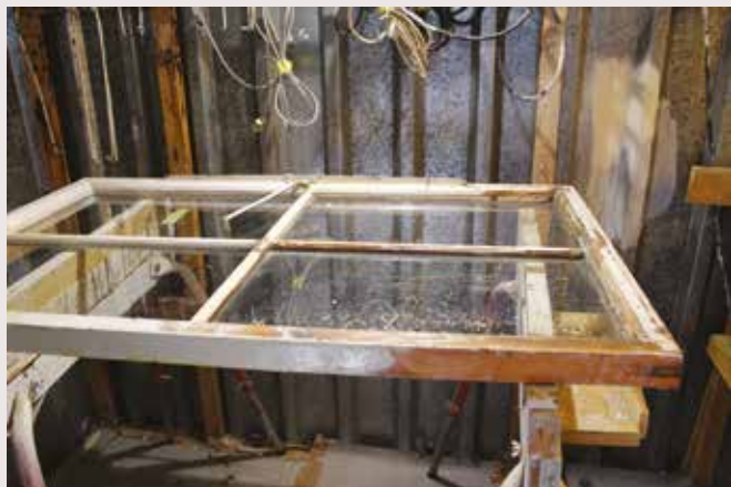
Alt den løse maling er skrabet af rammen, og den er klar til at blive genbehandlet med maling.
