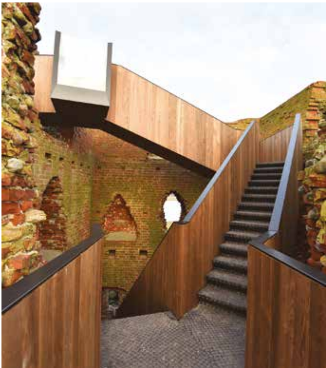
Trappetårnet er konstrueret så det hviler på fire punkter i ruinen.
