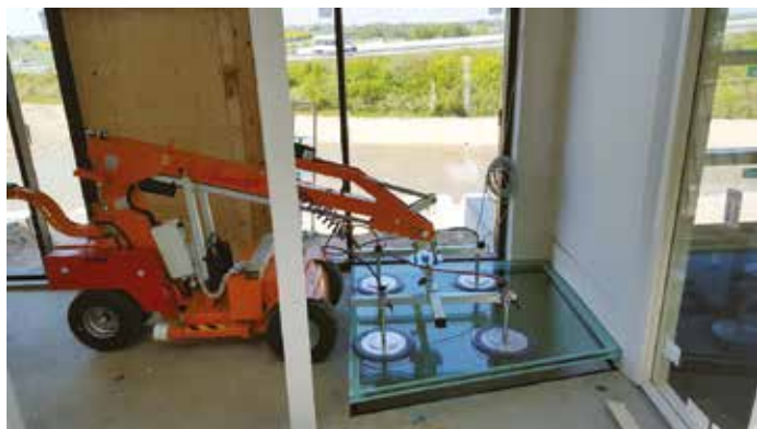
Her ses arbejdet med at ligge de tunge gulvglas på plads.
