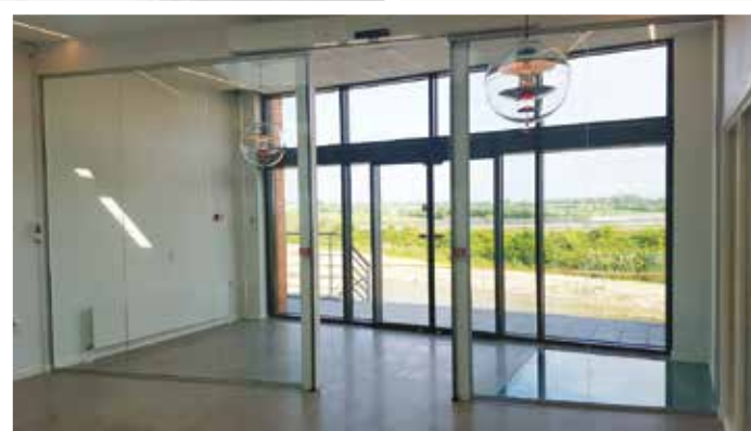
Her ses det færdige gulvglas, samt skydedørene imellem vindfanget. og receptionen.
