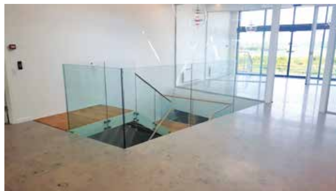
I baggrunden ses afskærmningen imellem receptionen og trappen. Ligesom glasvæggen er resten af glasværnet udført i lamineret glas.
