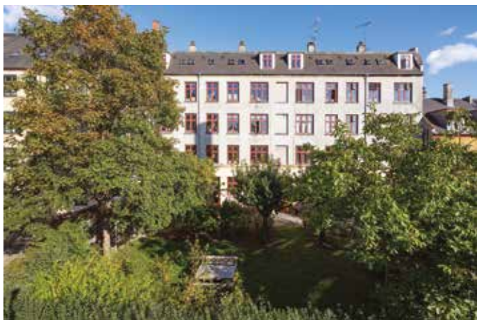
Valby Project før
