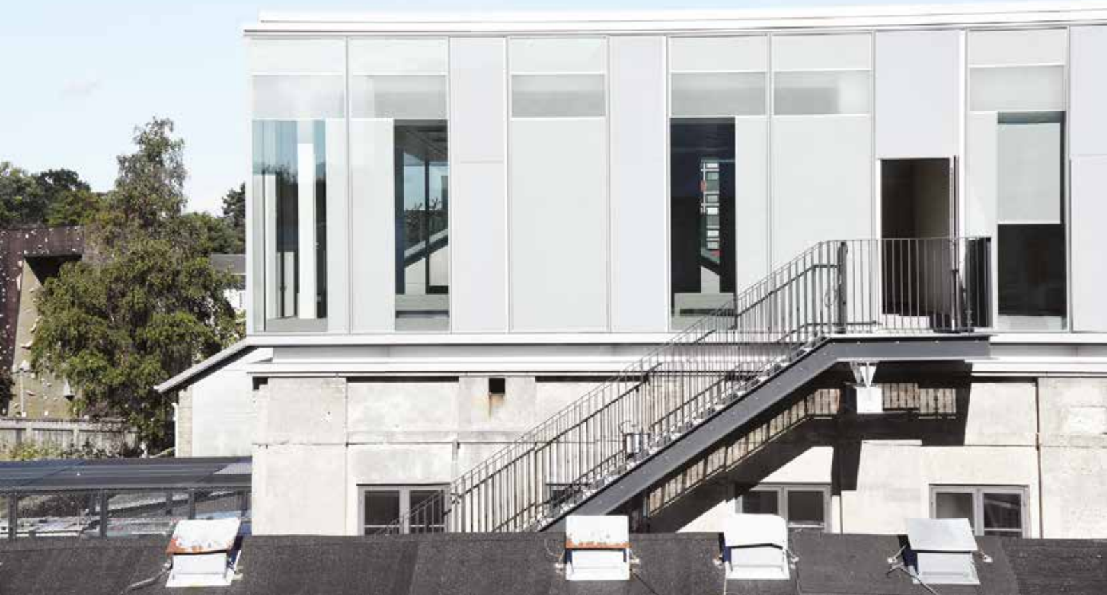
På særligt solrige dage kan facaden varme - og lysdæmpes med screens med manuel, umotoriseret betjening. Det er jo et institut for legemsøvelser!
