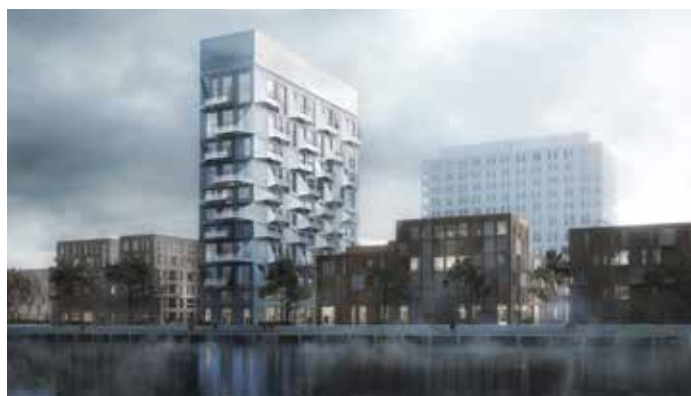
Efter: Fra kornsilo til Danmarks dyreste lejlighed kræver en stor forvandling. Glas og altaner er med til at give størst mulig oplevelse af havn og by.
