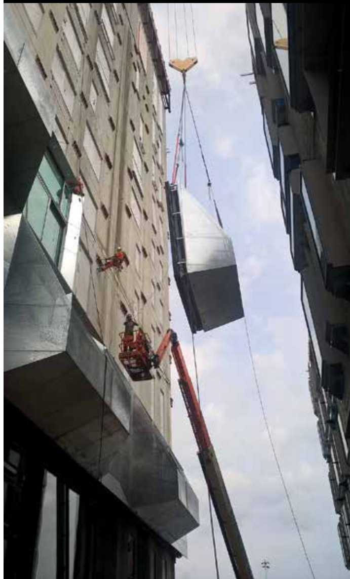
Et færdig modul er ved blive hejst på plads.
