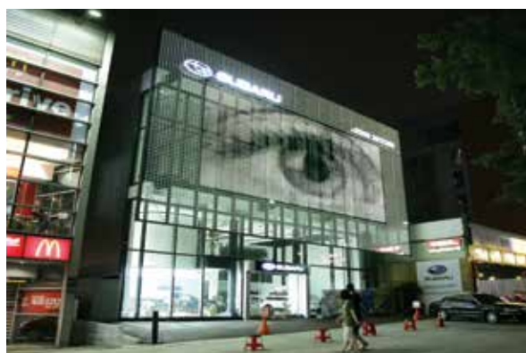
Powerglass fra Glas Platz i Tyskland er anvendt til denne facade, der annoncerer for et bilmærke.
