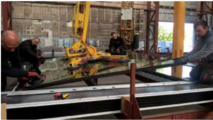
Trelags energiruder er ved at blive monteret i et næsten færdig modul.
