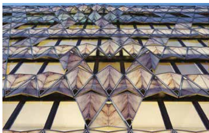
Dip-Tech, Origami Building, Paris, Frankrig Arkitekt: Manuelle Gautrand, Glas: TVG Lamineret glas Producent: Interpane Sicherheitsglas GmbH
