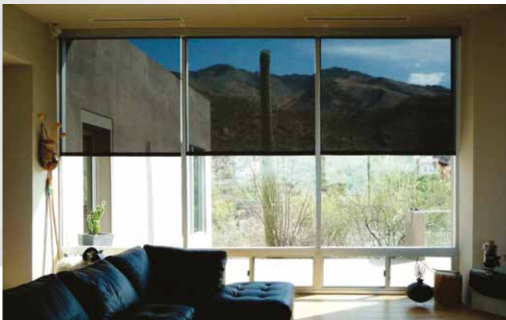
Eksempel på energiruder med solreducerende belægning, kombineret med en indeliggende screen.
