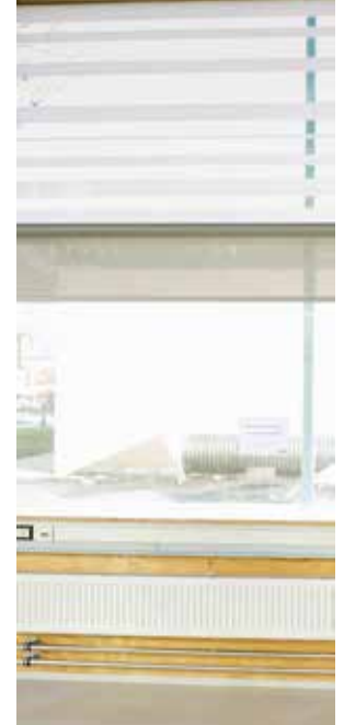
Den indvendige solafskærmning består af manuelt betjente, translucente screens. Med manuel styring opnås fleksibilitet og en bedre brugeropfattelse af effekten. Foto: Friis & Moltke.
