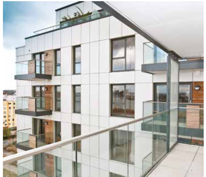
Værnparti, udført med Taper-Loc® fra C.R. Laurence
