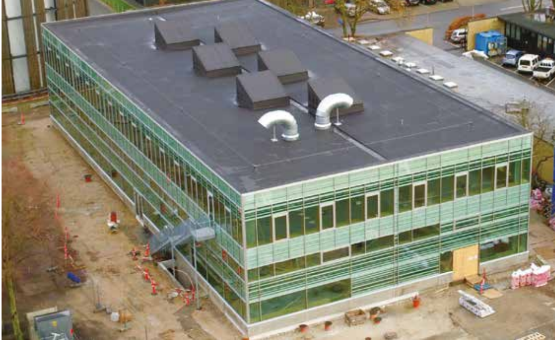
Bygning 409 til DTU Campus Service, CAS, er opført med energiruder i mange formater på alle fire facader, påført solafskærmende striber med en glass-jet trykteknologi. Foto. Kontraframe.
