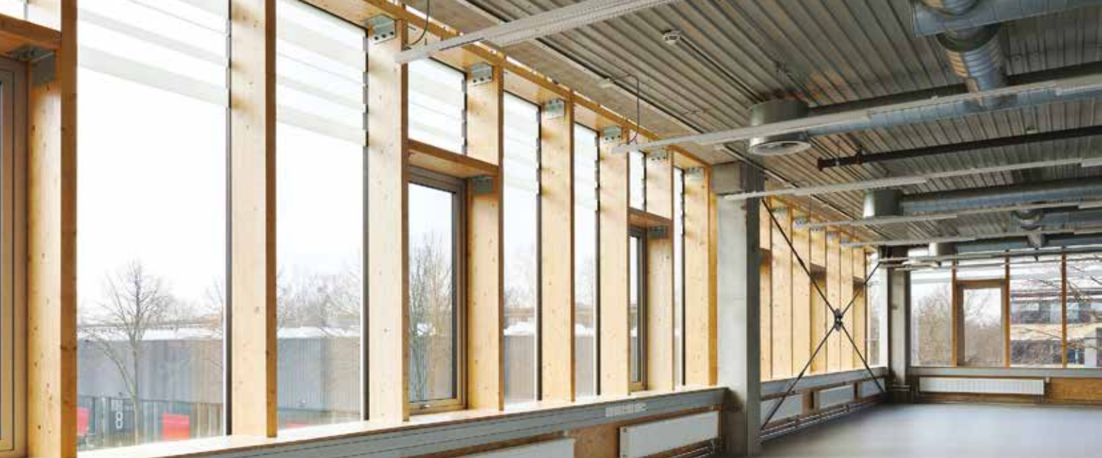
Det grid, som ruderne er monteret på, er udført af limtræsbjælker, afsluttet med aluminiumsprofiler – i sig selv en udfordring for facadeentreprenøren. Foto: Stammers Kontor.
