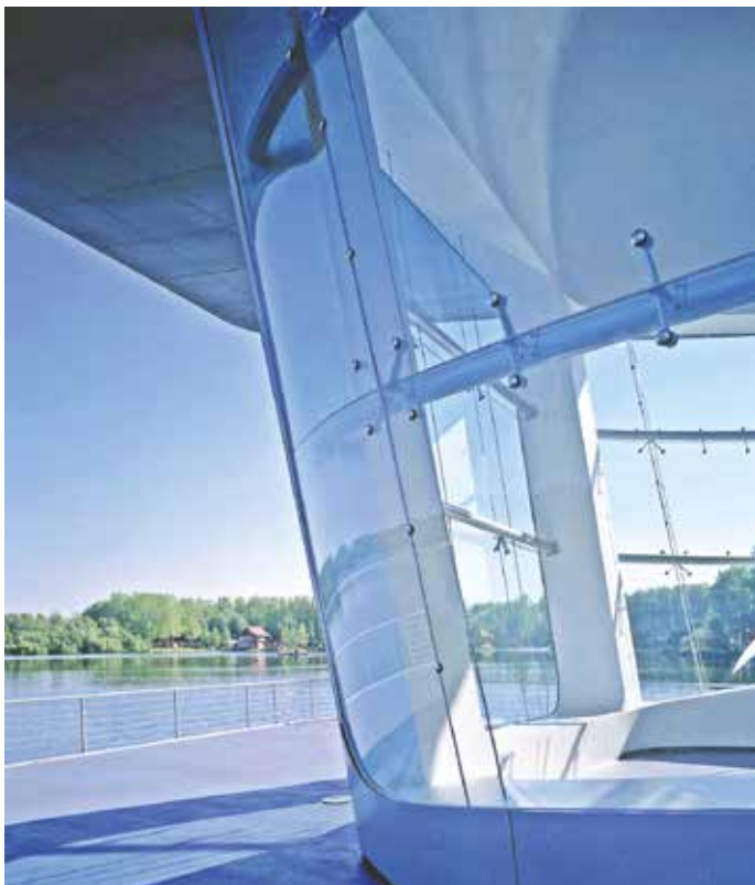
Punktmonteret bøjet glas, de 3 glas tv er 12mm hærdet glas bøjet traditionelt ved varme, de øvrige glas er 12mm lamineret hærdet glas kold-bøjet under monteringen. Floride pavillonen 2002, Haarlemmeer, NL (© Octatube).
