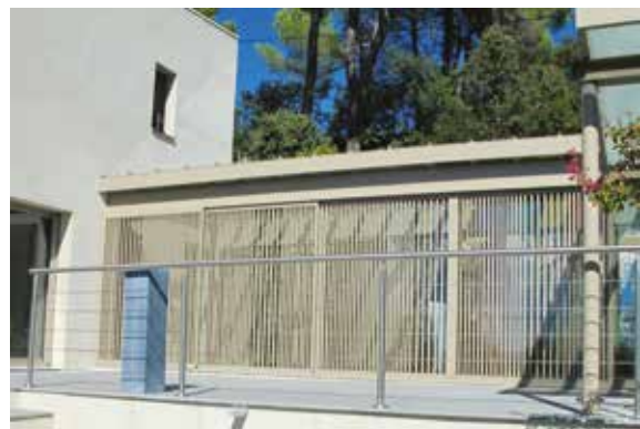
facade med solafskærmende skodder.
