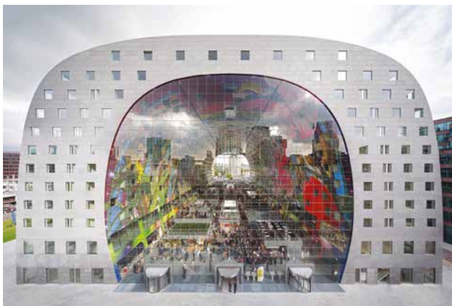
Europas største kabel-glasfacade på 34 x 42 m (-® Ossip van Duivenbode).
