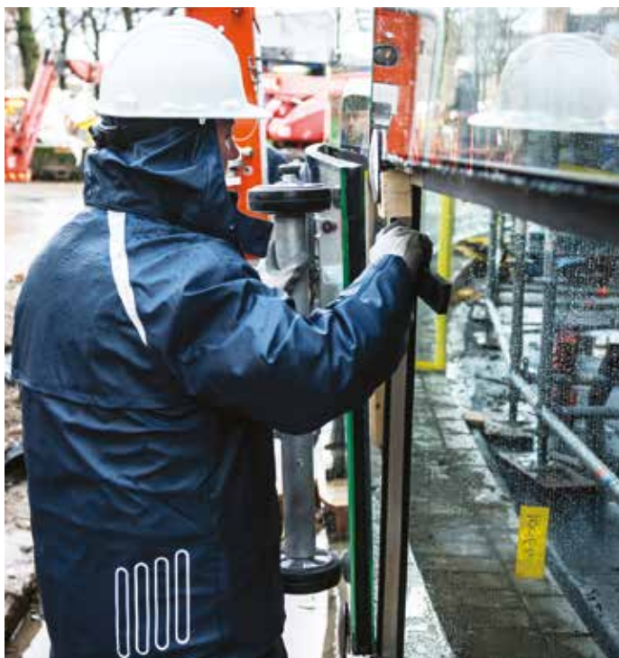
2-lags isolerings ruder kold-bøjes på plads i facaden (© Van Gogh Museum).
