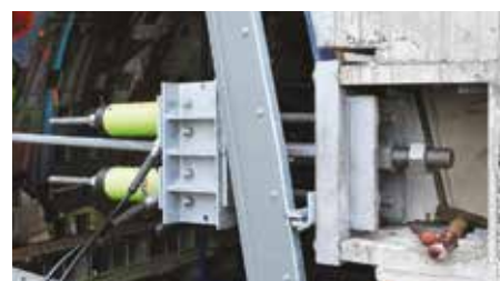
Hydraulisk forspænding af kablerne med op til 300 kN det strækker dem med 10 til 15 cm (® Octatube).
