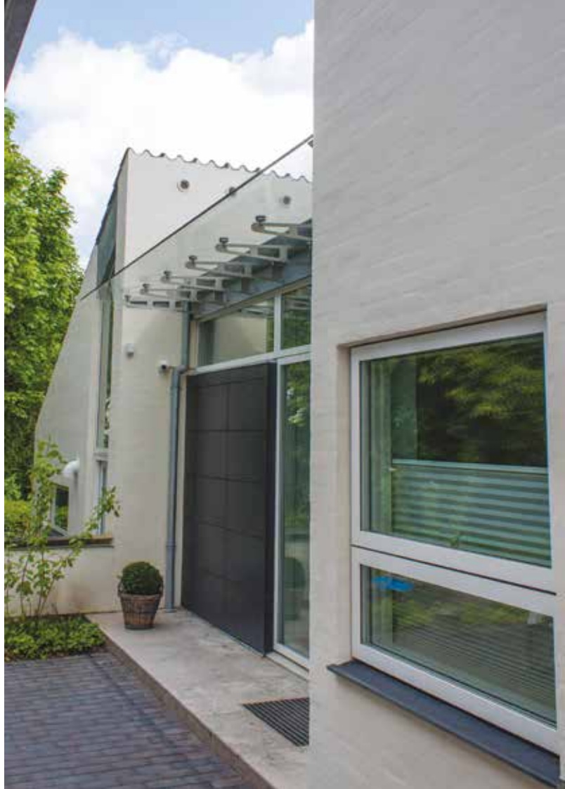
Glasbaldakinen skulle nøje afstemmes efter husets designlinje. Konstruktionen svæver let henover indgangspartiet, som er en smule tilbagetrukket fra den øvrige facade.
