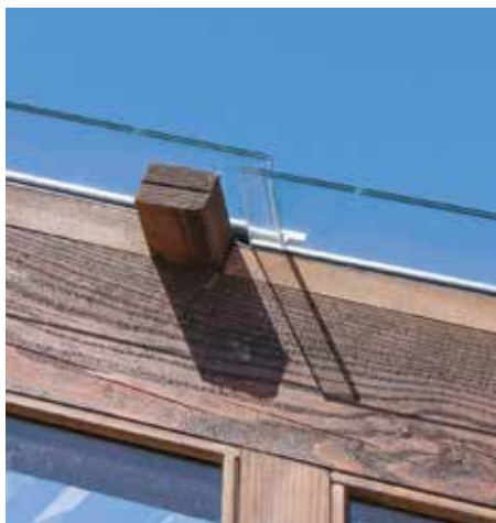
Taget er udført i 4x4 mm hærdet lamineret glas som overlapper hinanden med en 3-4 mm luftsprække. Foto: Linette Bekhøj
