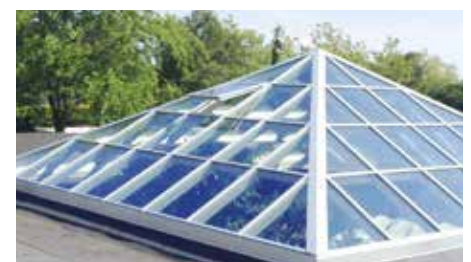
Færdig - glas og øvrigt monteret er gjort efter opkraning.
