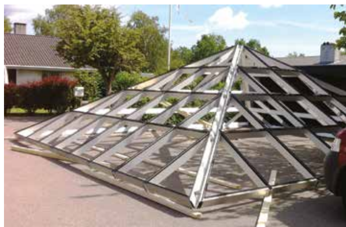
Pyramidens hovedkonstruktion bygges på terræn.
