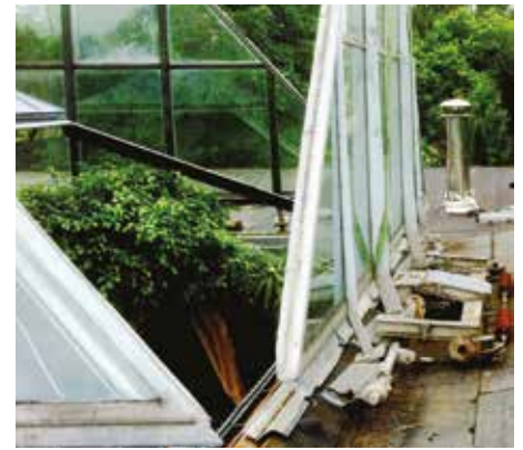
Gamle pyramide med gående glassider og hejsemotorer.
