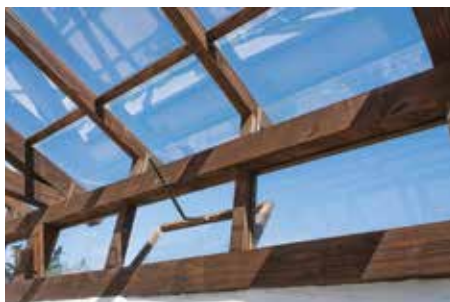
Både vinduer og en luftsprække øverst sørger for naturlig ventilation i drivhuset. Foto: Linette Bekhøj
