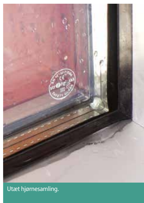
Utæt hjørnesamling. Saneres ved rengøring, nye lister og tætning med Schüco Flex og brug af korrekte materialer.
