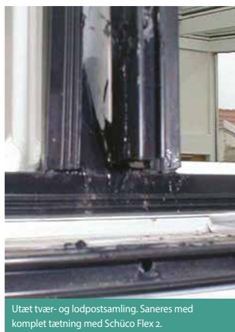
Utæt hjørnesamling. Saneres med nye lister og tætning med Schüco Flex.
