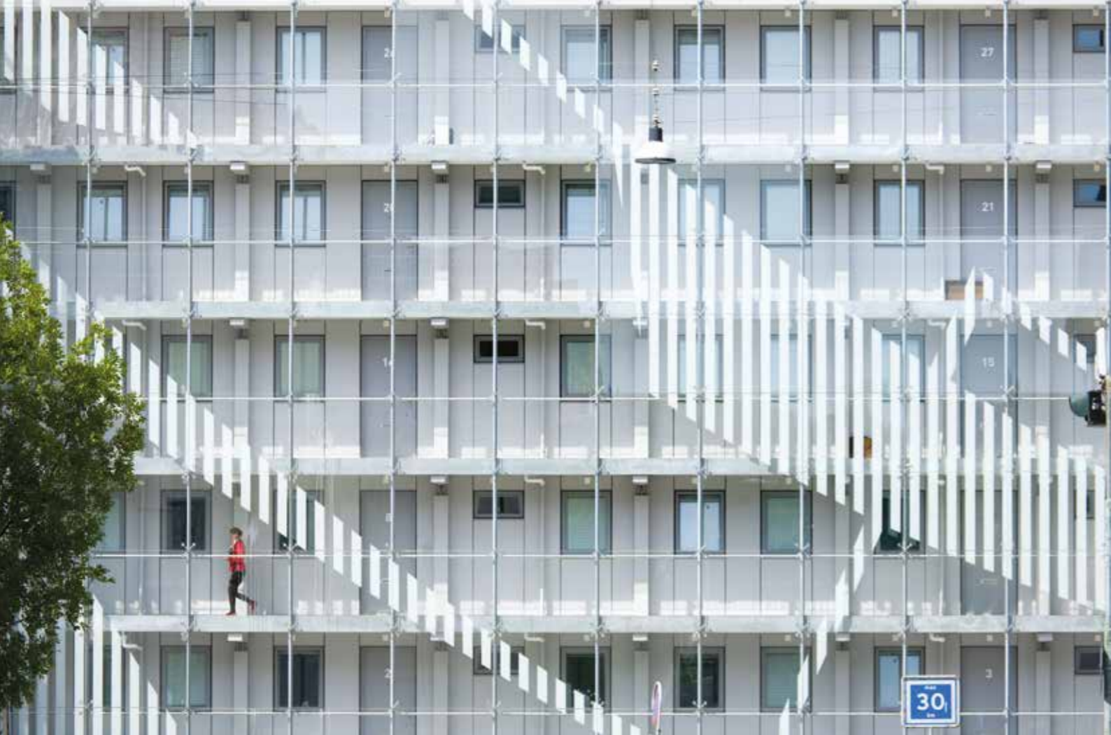
Lundtoftegade 9-81: Renovering af alment boligbyggeri har pakket facadernes altangange ind i glas efter et projekt af Pålsson Arkitekter A/S. Bygherre er KAB. Foto: Pålsson Arkitekter
