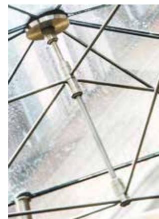
▲ Samlingsrosette, konisk stålribbe med glasbærere og rustfri bærestok med justeringspunkter.
