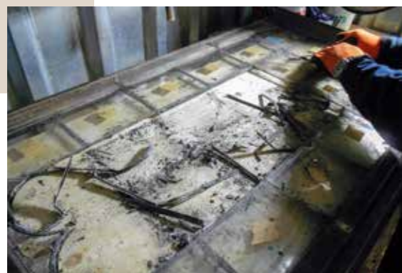
Første led i en omsamling er nummerering af glassene og afmærkning af blyprosper. De første blyprosper og glas fjernes i midten af ruden.
