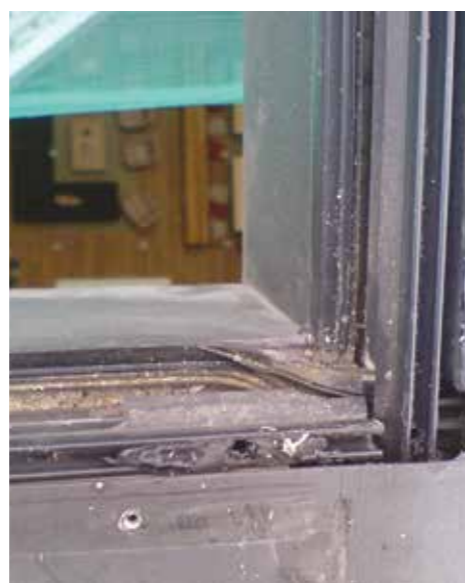
Utæt hjørnesamling. Saneres med nye lister og tætning med Schüco Flex.
