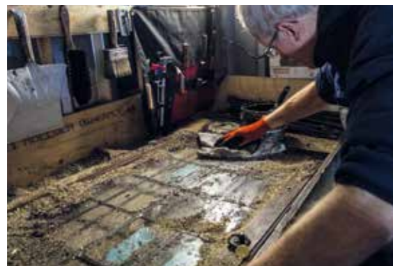
Alle rudens revner og sprækker mellem glas og bly tættes med fortyndet linoliekit og renses herefter med savsmuld.
