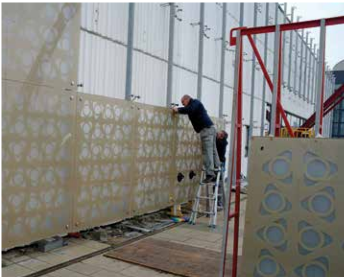
Montering af facadeglas med silketryk.
