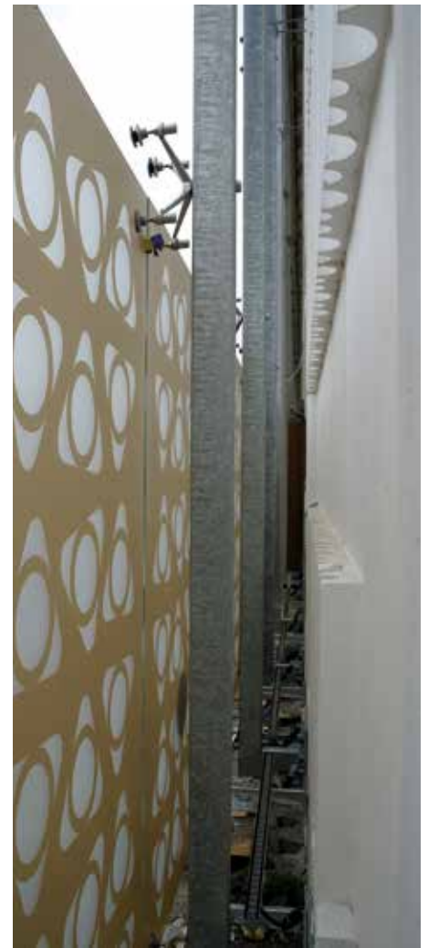
Montering af facadeglas med silketryk.
