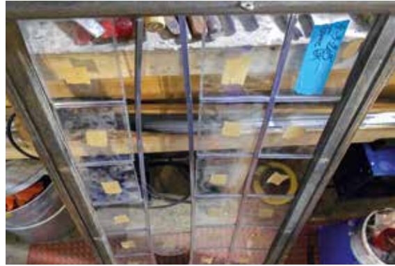
Omsamlingen starter med rudens top og sider. Den sidste bane af glas skubbes på plads. De lodretgående blyprosper trækkes af glasset og klippes derfor først af til sidst.
