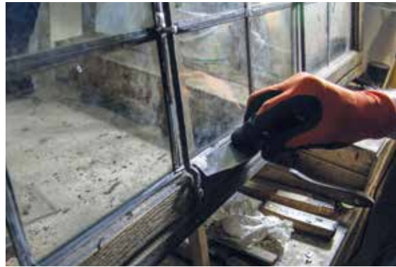
Når den færdige rude skal kittes i rammen har Jesper Jensen lavet et specialværktøj til kitning under vindjernet.
