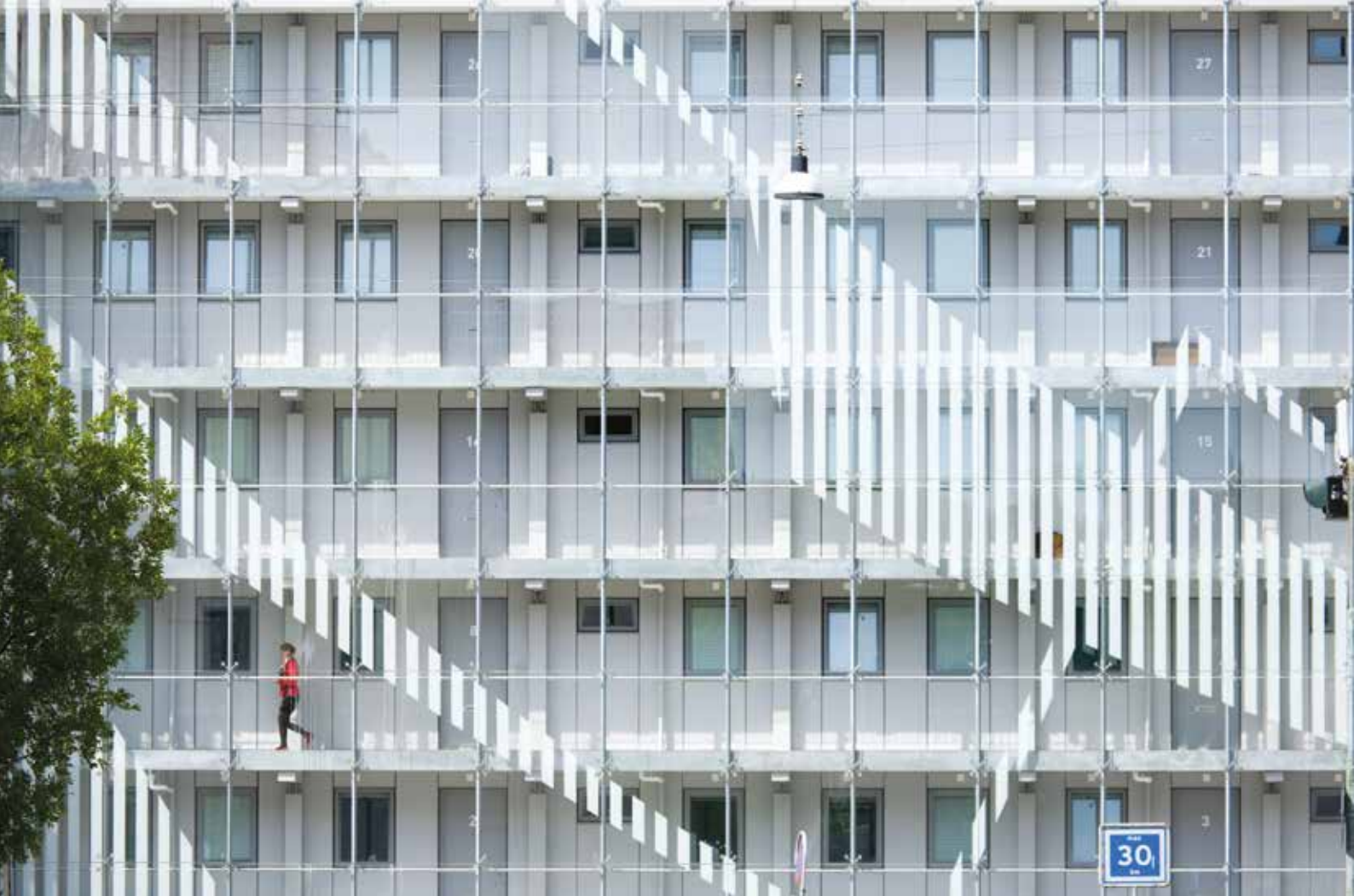
Lundtoftegade 9-81: Renovering af alment boligbyggeri har pakket facadernes altangange ind i glas efter et projekt af Pålsson Arkitekter A/S. Bygherre er KAB. Foto: Pålsson Arkitekter
